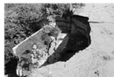
El funcionario precisó que el daño de este tramo sobre el carril de acotamiento es derivado de un pluvial con fallas colindante a la carretera.
