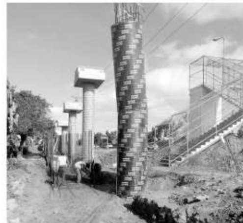
Las obras de corrección de errores del puente Machado aún no tienen fecha de conclusión.
