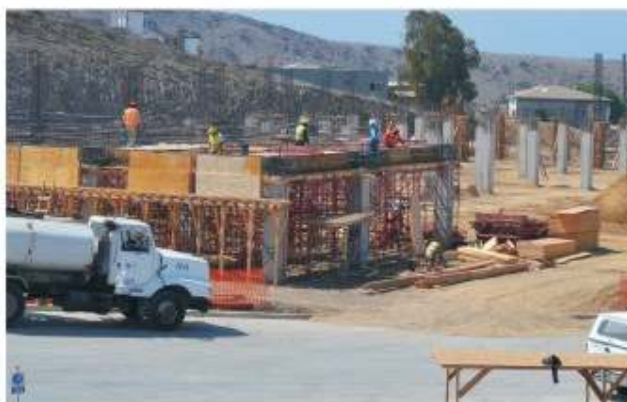
Autoridades municipales hicieron un recorrido por la obra de la nueva clínica del seguro social.
