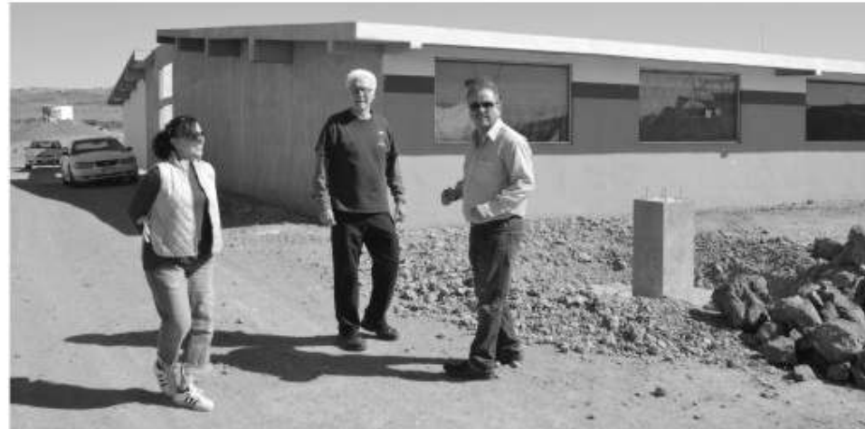
Promotores del proyecto revisan las obras de instalación de luminarias.
